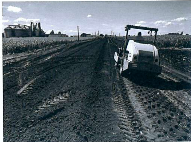
Figura 5: Compactação com rolo da estrada
