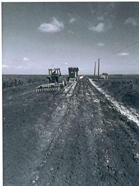
Figura 3: Incorporação do produto na camada de 20 cm
